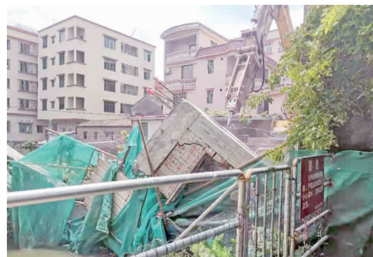
■执法人员出动炮机对违建房屋进行依法拆除。
